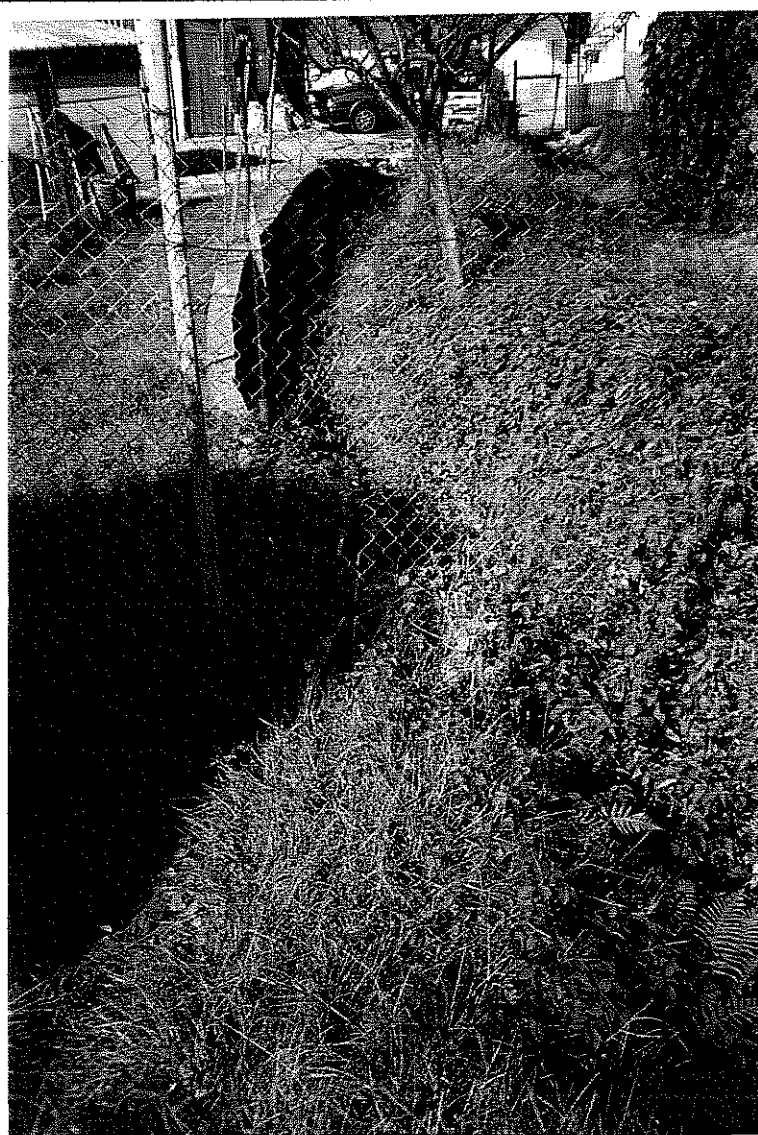
FOTO n°5 – Derivazione con paratoia in pietra che convoglia parte delle acque nel tubo a sezione circolare che scorre al di sotto di un abitazione. Si tratta di un cattivo esempio di modifica del tracciato originario del canale.
