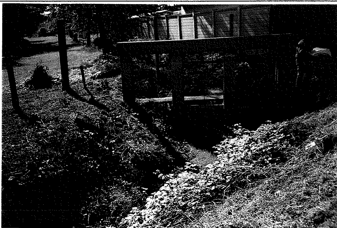
FOTO n°2 – Particolare di una paratoia con struttura in pietra; come si può notare la sezione originaria del canale era decisamente più ampia ed in particolare la derivazione di sinistra è ormai inattiva.
