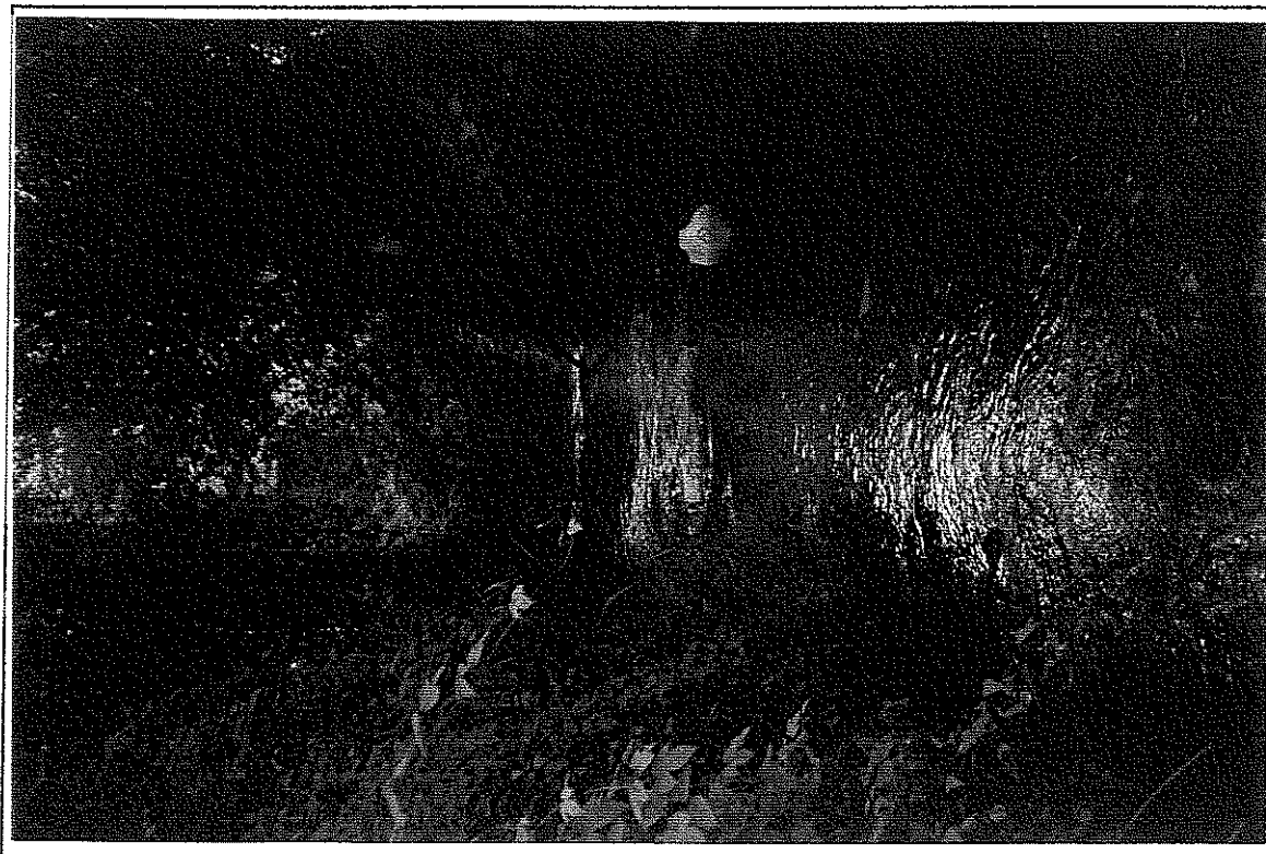
FOTO n°4 - In questo tratto il canale ha mantenuto la sua tipologia originaria, con sezione di ampiezza maggiore e presenta un rivestimento in ciottoli e mattoni.
