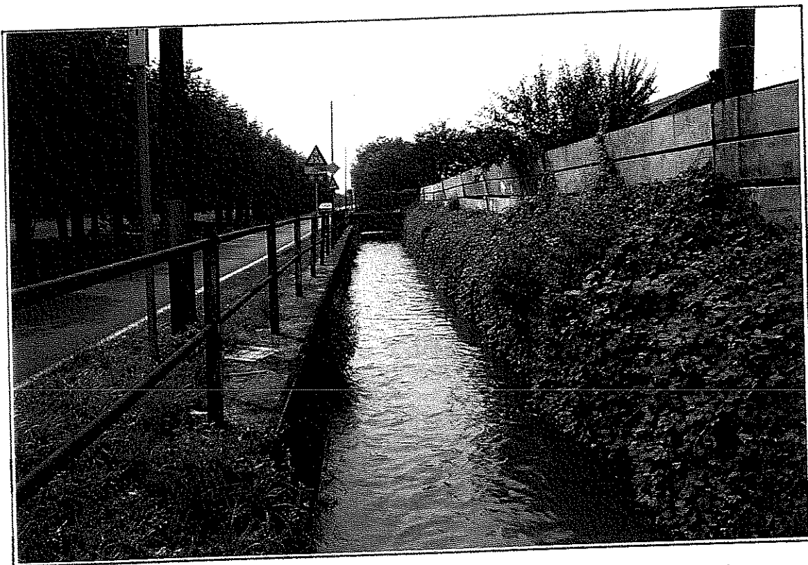
FOTO n°1 – La bealera costeggia via Don Sapino: la sponda sinistra è generalmente in terra, mentre sulla destra la delimitazione è costituita da un muretto in calcestruzzo
