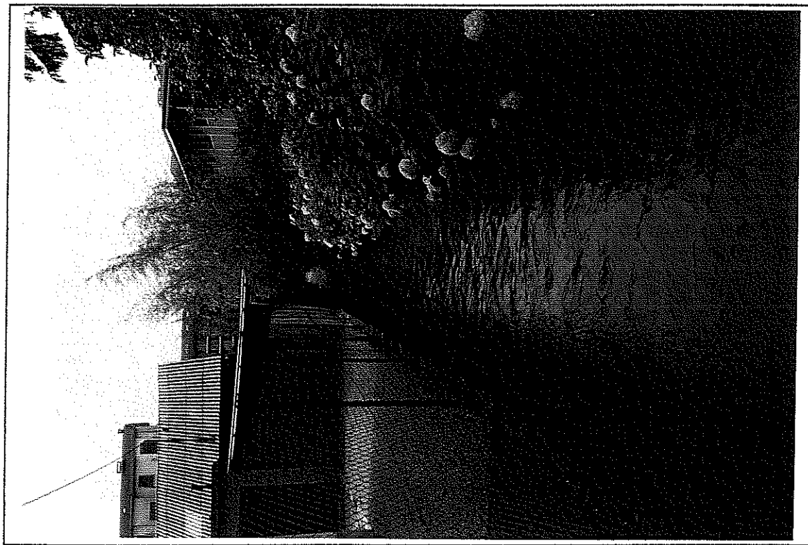
FOTO n°3 - Il canale scorre in mezzo alle case, la sezione perfettamente rettangolare è delimitata anche in questo caso sulla destra da un muretto in calcestruzzo che costituisce anche il basamento per una recinzione e per una "tettoia ripostiglio", dall'altro lato una piacevole siene verde.
