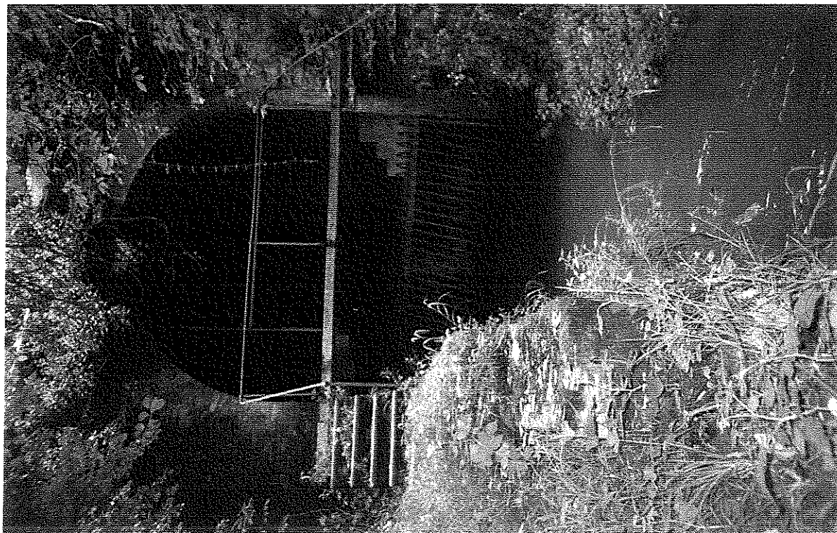
FOTO n°7 -- Locale paratoie di pregevole fattura con soffitto a volta in mattoni, che rappresenta l'inizio del tratto di canale in galleria
