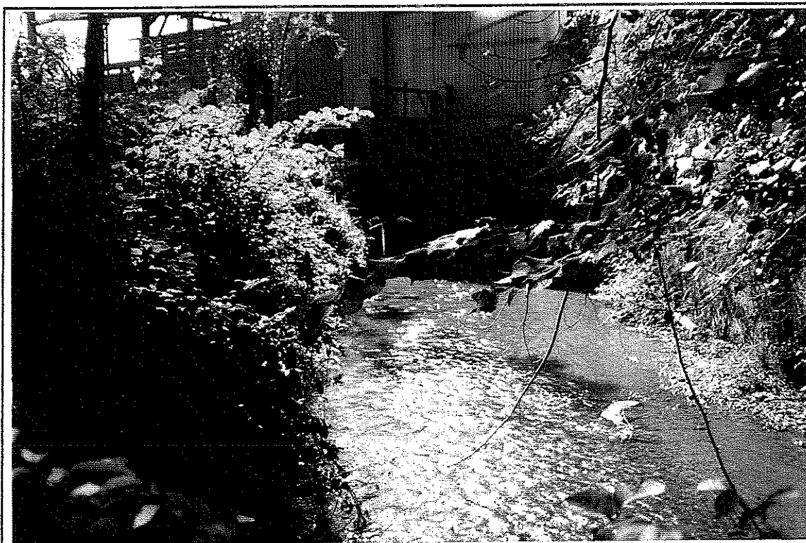
FOTO n°5 – Derivazione con paratoia in pietra che convoglia parte delle acque nel tubo a sezione circolare che scorre al di sotto di un abitazione. Si tratta di un cattivo esempio di modifica del tracciato originario del canale.
